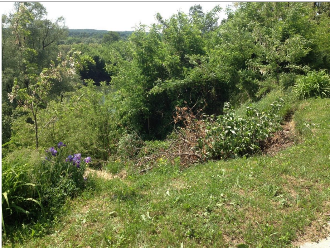
Klizište uz cestu na središnjem dijelu rječne krivine – predviđena lokalna sanacija
