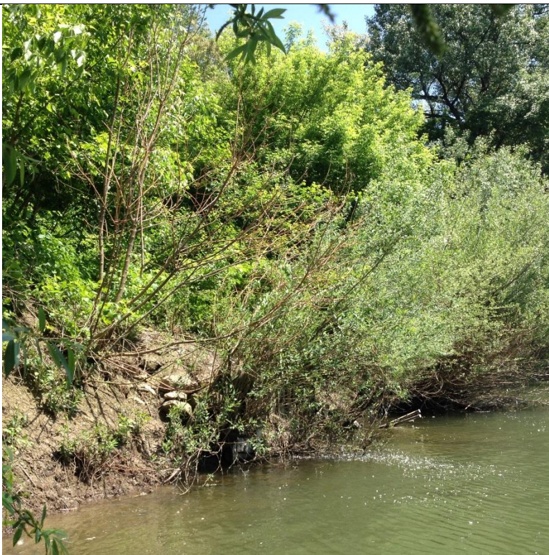
Strma obala Kupe u nizvodnom/izlaznom dijelu kupske krivine s nekoliko klizišta
