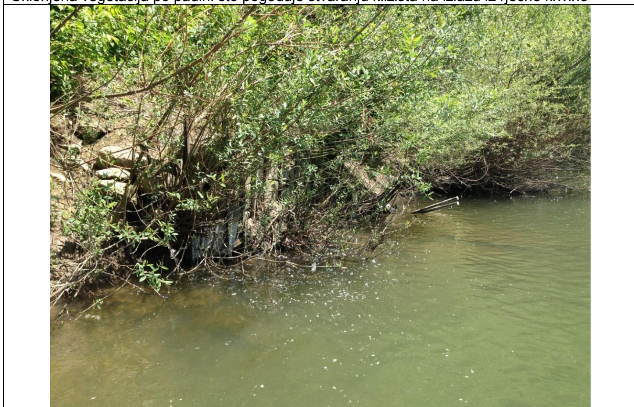
Interventne mjere sanacije obale talpama, želj. šinama i gredama na izlazu iz rječne krivine
