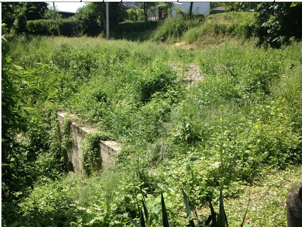
AB podgrada s propustom za sanaciju odrona uz cestu u središnjem dijelu rječne krivine
