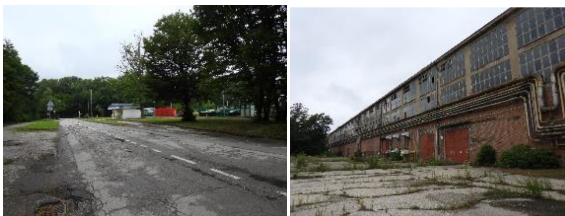
Fotografija 3-21: Postojeća prometnica na sjevernom rubnom dijelu zahvata uz postojeće reciklažno dvorište (lijevo) te prostor nekadašnje željezare Sisak (ABS Sisak d.o.o.) u širem području zahvata (desno)
