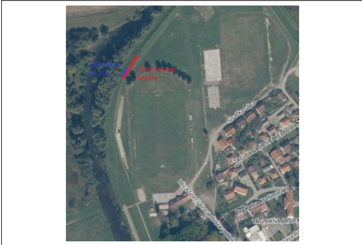
Slika 1. Prikaz dijela nasipa na kojem su uočena oštećenja; Izvor: Projektni zadatak. Projekt održavanja desnog obalnog nasipa rijeke Gline u n.km 0+650, u Glini, Sisačko -moslavačka županija, Hrvatske vode, Vodnogospodarski odjel za srednju i donju Savu, travanj 2021.
