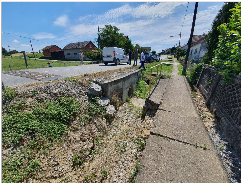
Slika 8. Detalj postojećeg cijevnog propusta u ulici braće Radić (Idejni projekt, DUEL PROJEKT d.o.o., rujn 2021.)
