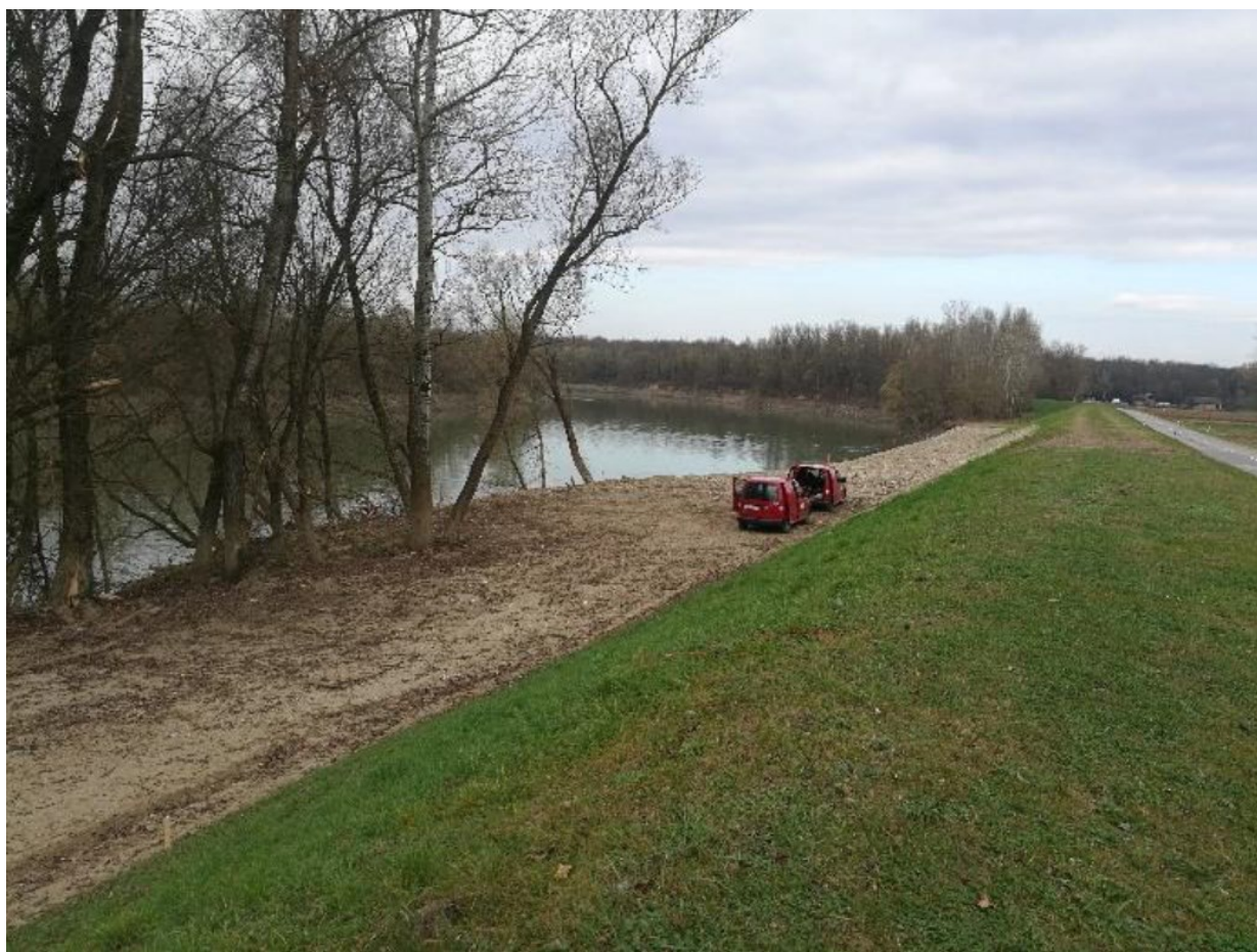
Slika 2.5 Pogled s nasipa uzvodno (Izvor: Idejno rješenje)
